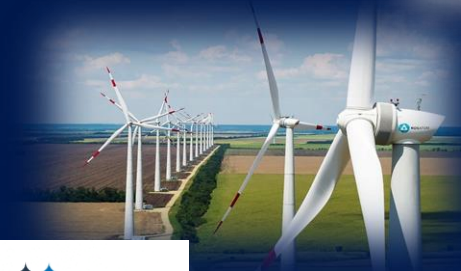
Берестовская ВЭС 60 мВт
