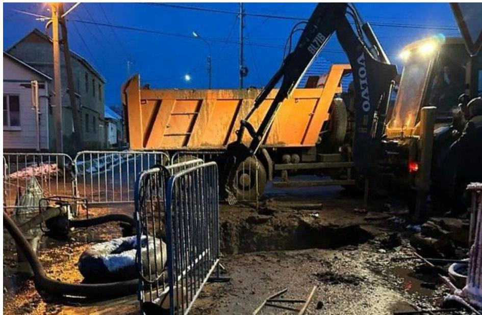
20 ноября 2023 года произошло обрушение канализационного колодца глубиной 6 метров. Для устранения аварии круглосуточно работали 2 бригады «Ставрополькрайводоканала». Было задействовано 4 единицы спецтехники и 5 мотопомп для перекачки сточных вод.
